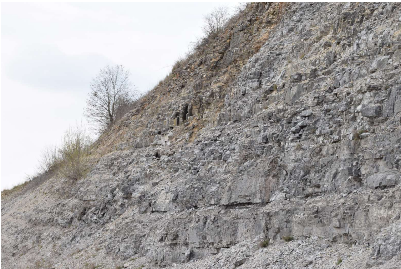
Photo 1 : Falaise au sud-est de la plateforme VLF, 03/2025
